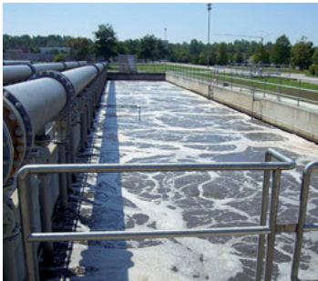
Kläranlage Gut Marienhof
